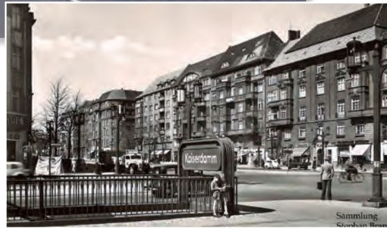
Blick auf das Haus Kaiserdamm 26
